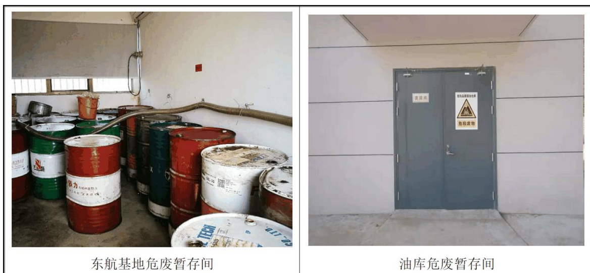
图 2.1-7 危险废物贮存场所
