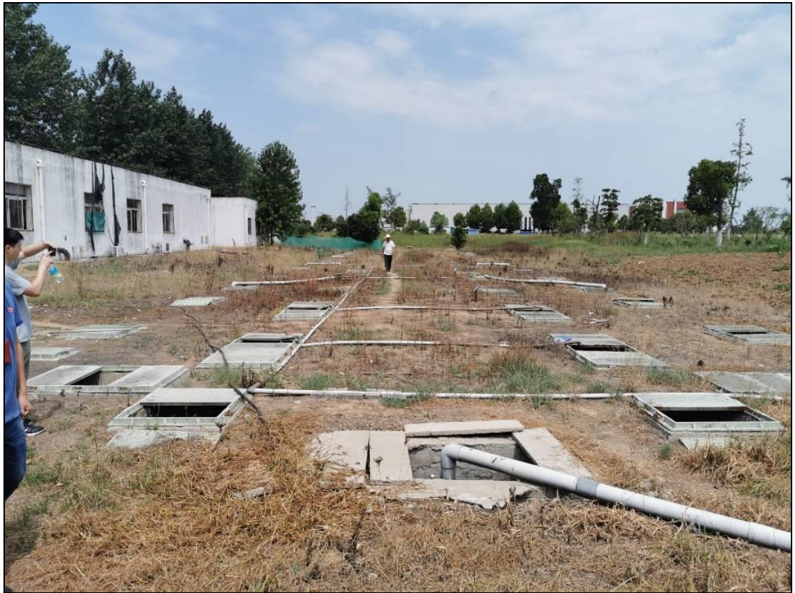
图 2.1-5 污水处理站现状图
